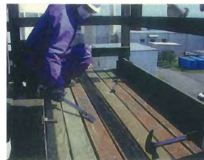
階段踊り場補修
