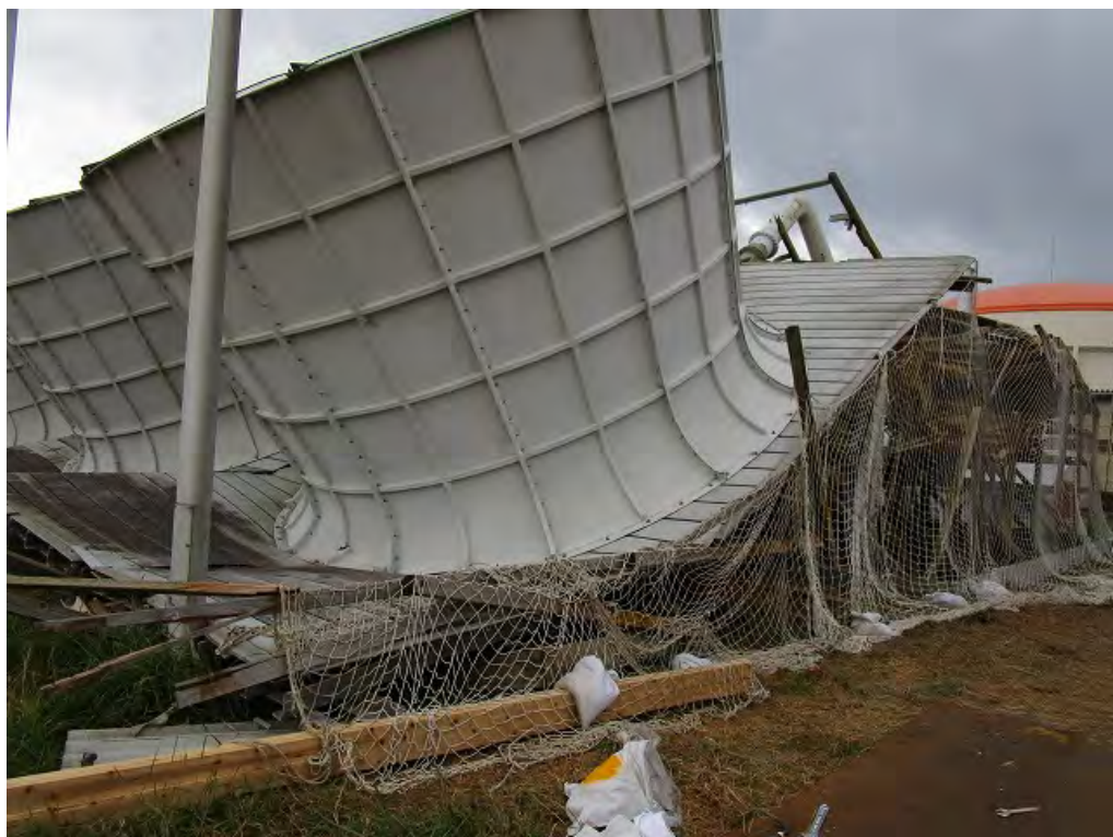
写真② 撤去中状況(南側) (令和元年10月24日撮影)
