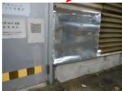
写真③ 補修後(1)（令和元年 9 月 9 日撮影）
