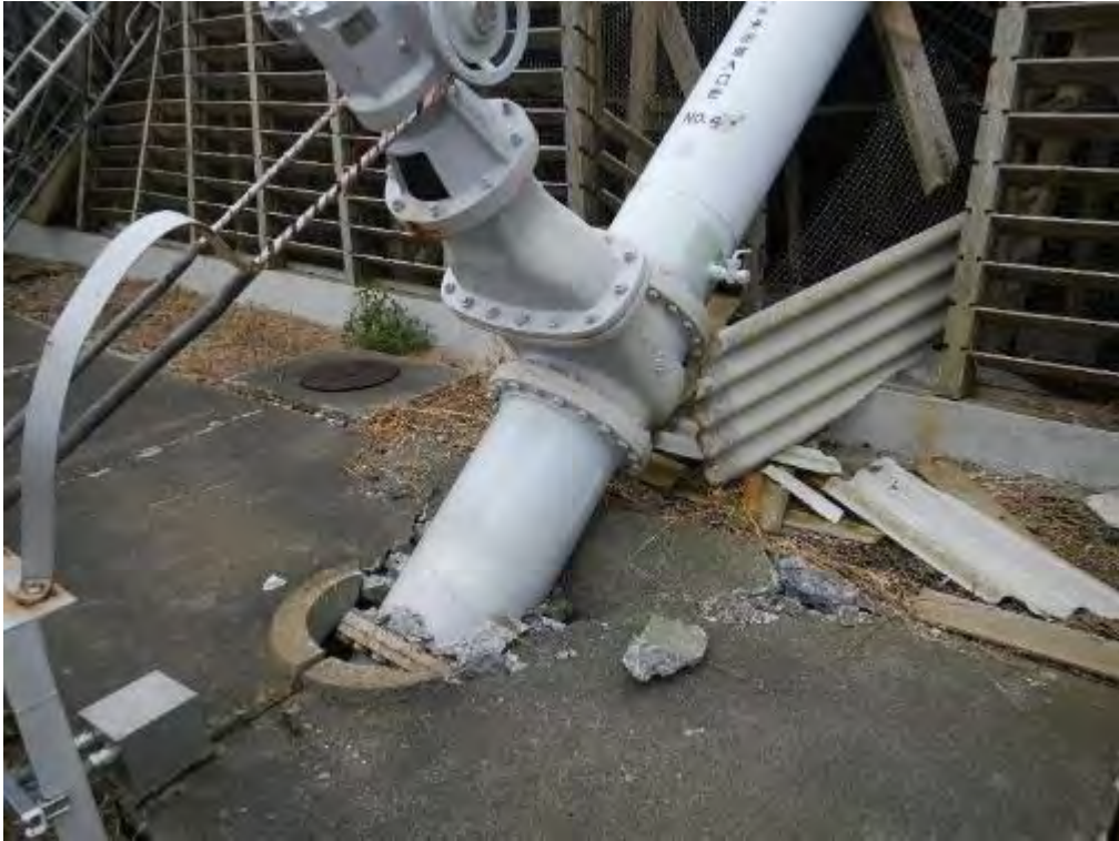
写真⑦ 二次冷却系配管 (No.4 セル側) 養生前 (令和元年 9 月 11 日撮影)
