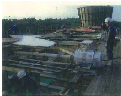
デッキ取外し
