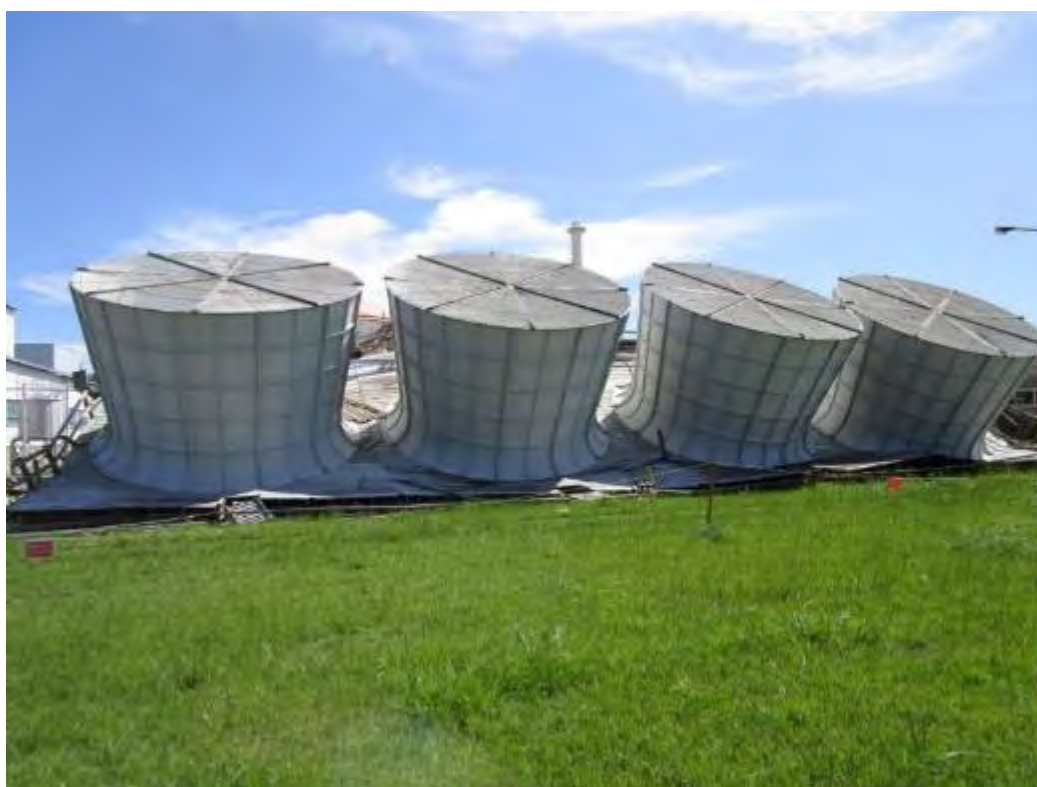
写真④ 倒壊後 西側（令和元年9月12日撮影）
