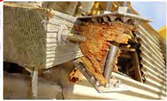
図④-7 冷却塔の南面における柱接合部等の詳細調査箇所
