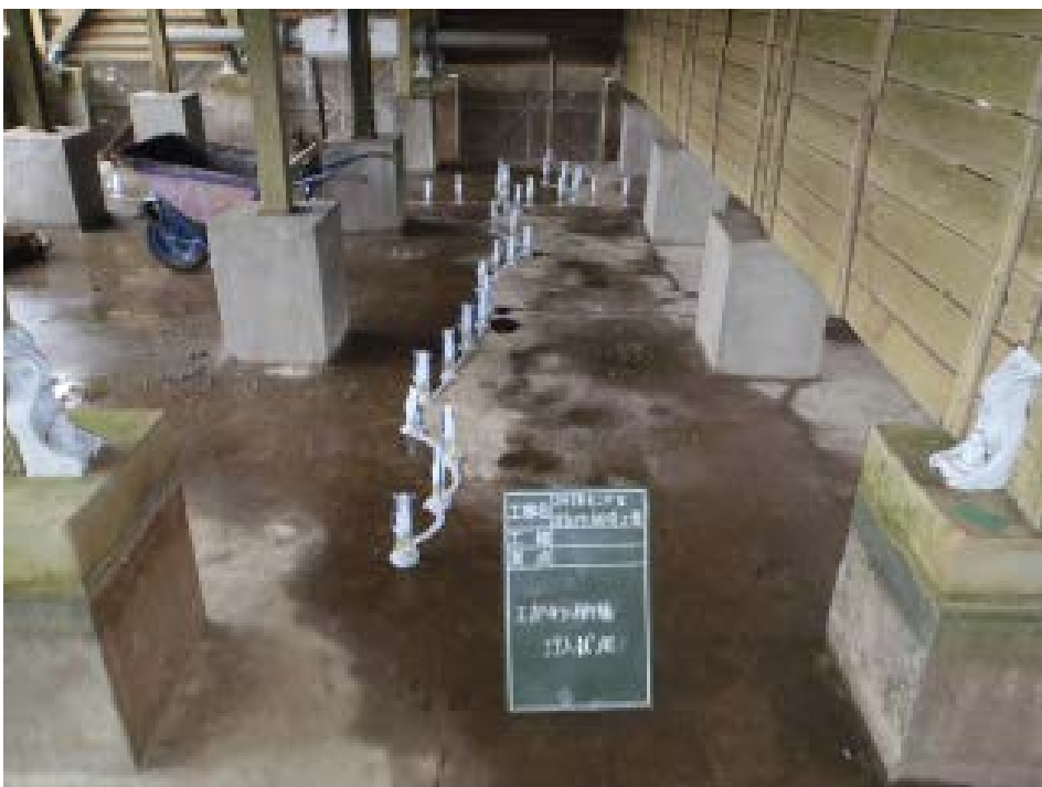
図①-4 低圧注入工法による補修時の写真
