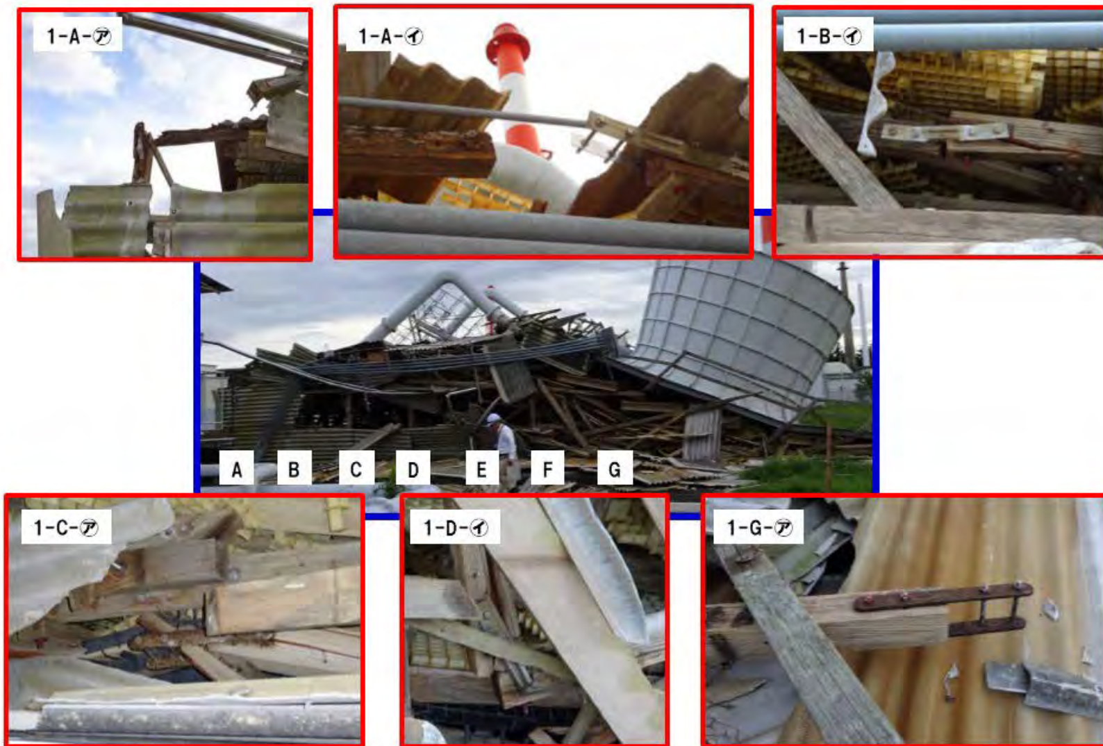
図④-3 冷却塔の北面における柱接合部の調査
