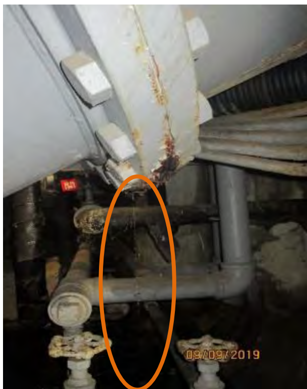
写真① 二次冷却系配管 止水前 (令和元年9月9日撮影)
