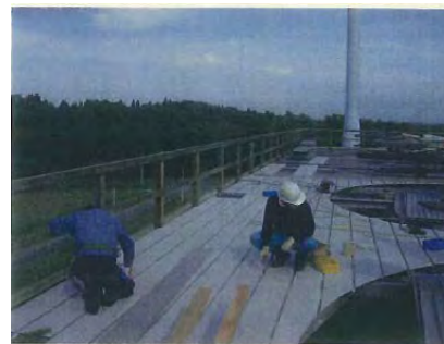
デッキFRP交換
