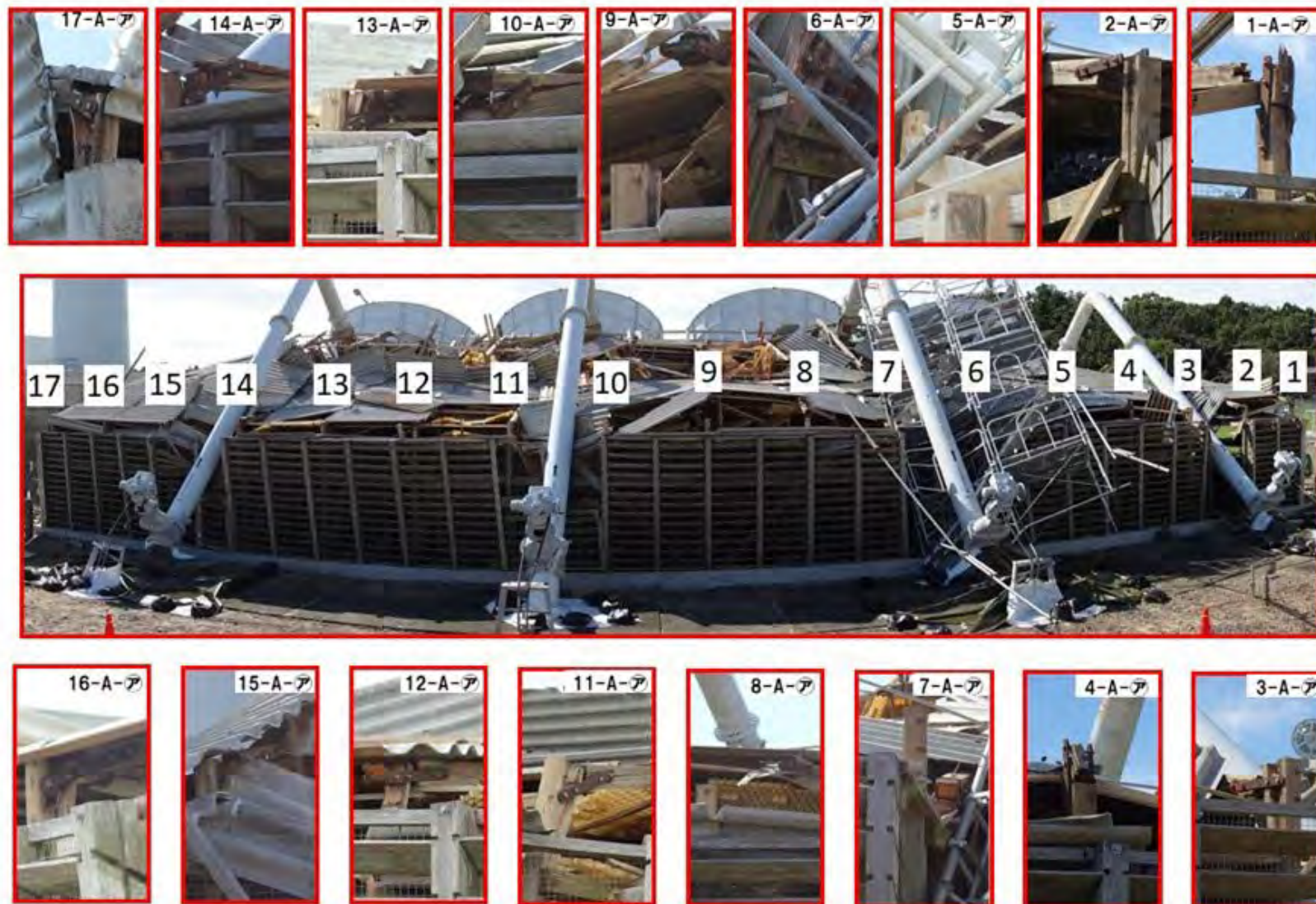
図④-2 冷却塔の東面における柱接合部の調査
