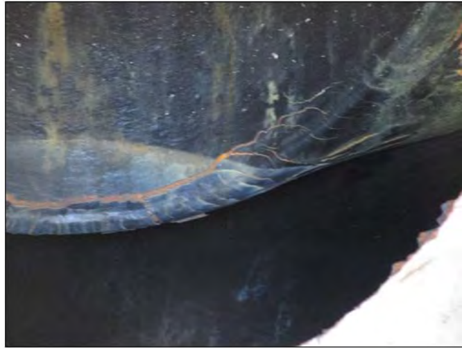
図⑰-4 立上げ配管 (No. 3) 内面部の詳細写真
